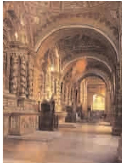
y seis capillas laterales intercomunicadas entre sí a través de la amplia perforación en arco de los contrafuertes de la bóveda central; cada capilla se cubre con cupulines de media naranja rebajada, con linternas.
